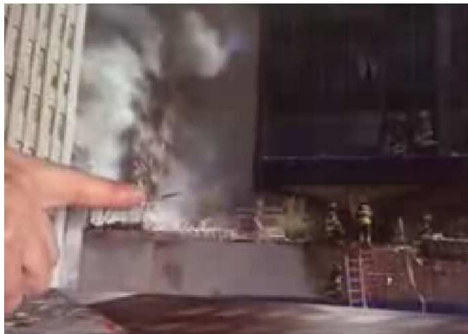
Fig. 3. Nouvelles photos montrant l'étendue des dommages
