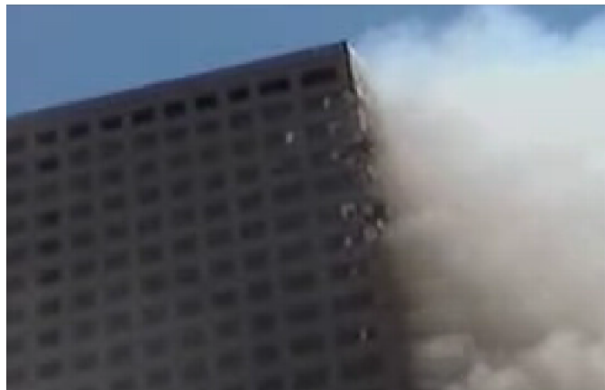
Fig. 5. Fumées, peu de flammes, dégâts limités
