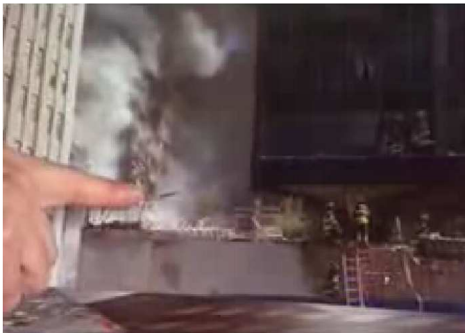
Fig. 3. Nouvelles photos montrant l'étendue des dommages
