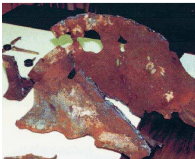
Fig. 6. Large flasque d'une poutre en acier du WTC7 avec érosion inhabituelle
