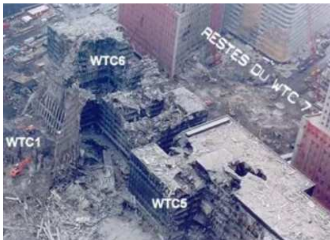
Fig. 8. Dégâts importants aux bâtiments WTC5 et WTC6, adjacents au WTC1, mais sans commune mesure avec le WTC7. De plus, ils sont toujours debout.
